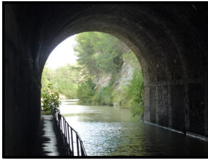
Ilustración 2. Túnel de Malpas (Fuente: TripAdvisor).
