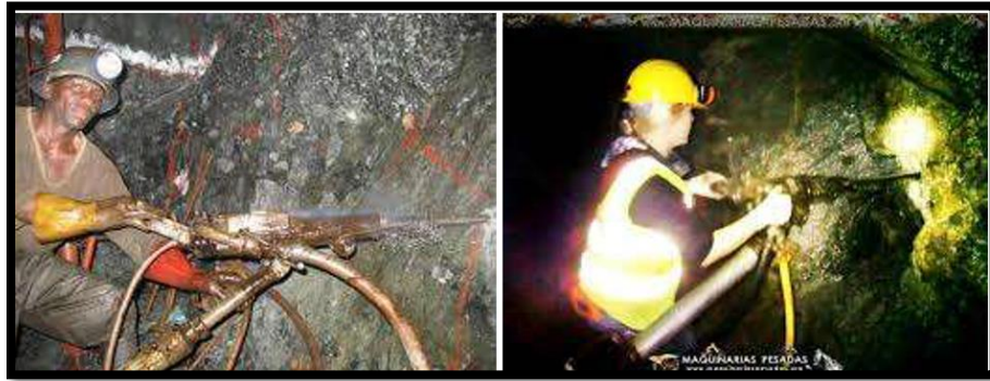
Ilustración 20. Perforación manual (Fuente: Tecnologías de excavación de rocas del módulo 2 , Berger , E).
